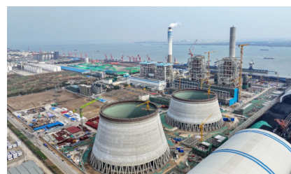
国信靖江 2×100 万千瓦机组 扩建项目施工现场
