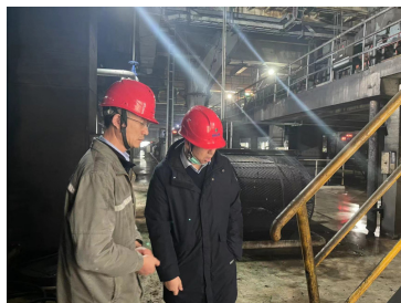
国信靖电开展“迎峰度冬”防寒防冻暨秋冬消防专项安全环保文明施工及燃气安全七防安防月度联合检查
